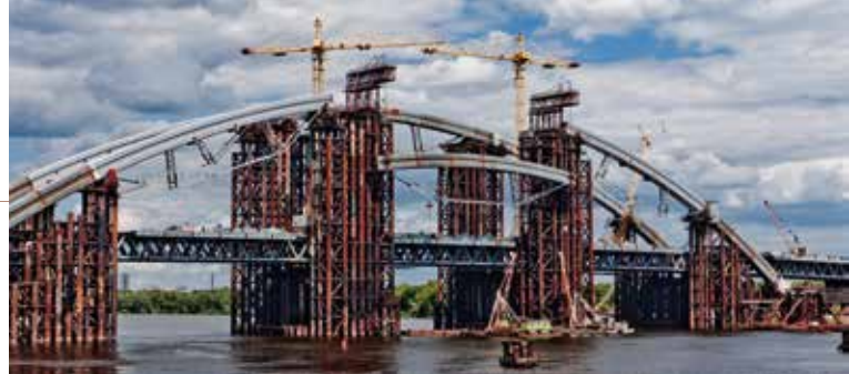
Investitionen in die Infrastruktur sind unumgänglich
